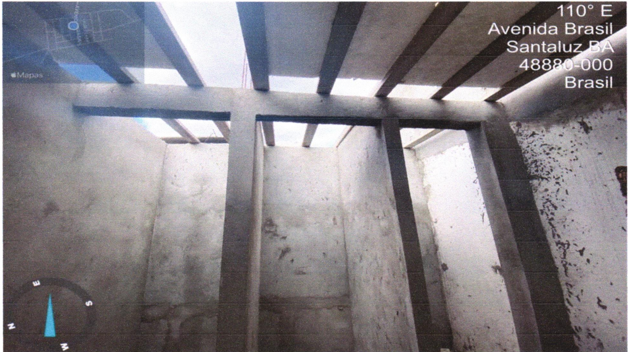
FOTO 20 - LAJE PRÉ-FABRICADA TRELIÇADA COM VIGOTA DUPLA PARA PISO, INTEREIXO 38CM, H=12CM, ENCHIMENTO EM BLOCO CERÂMICO H=8CM, INCLUSIVE ESCORAMENTO EM MADEIRA E CAPEAMENTO 4CM
