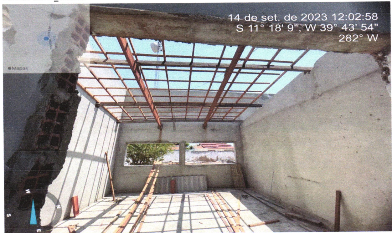
FOTO 04 - TRAMA DE MADEIRA COMPOSTA POR RIPAS, CAIBROS E TERÇAS PARA TELHADOS DE MAIS QUE 2 ÁGUAS PARA TELHA CERÂMICA CAPA-CANAL, INCLUSO TRANSPORTE VERTICAL. AF_07/2019
