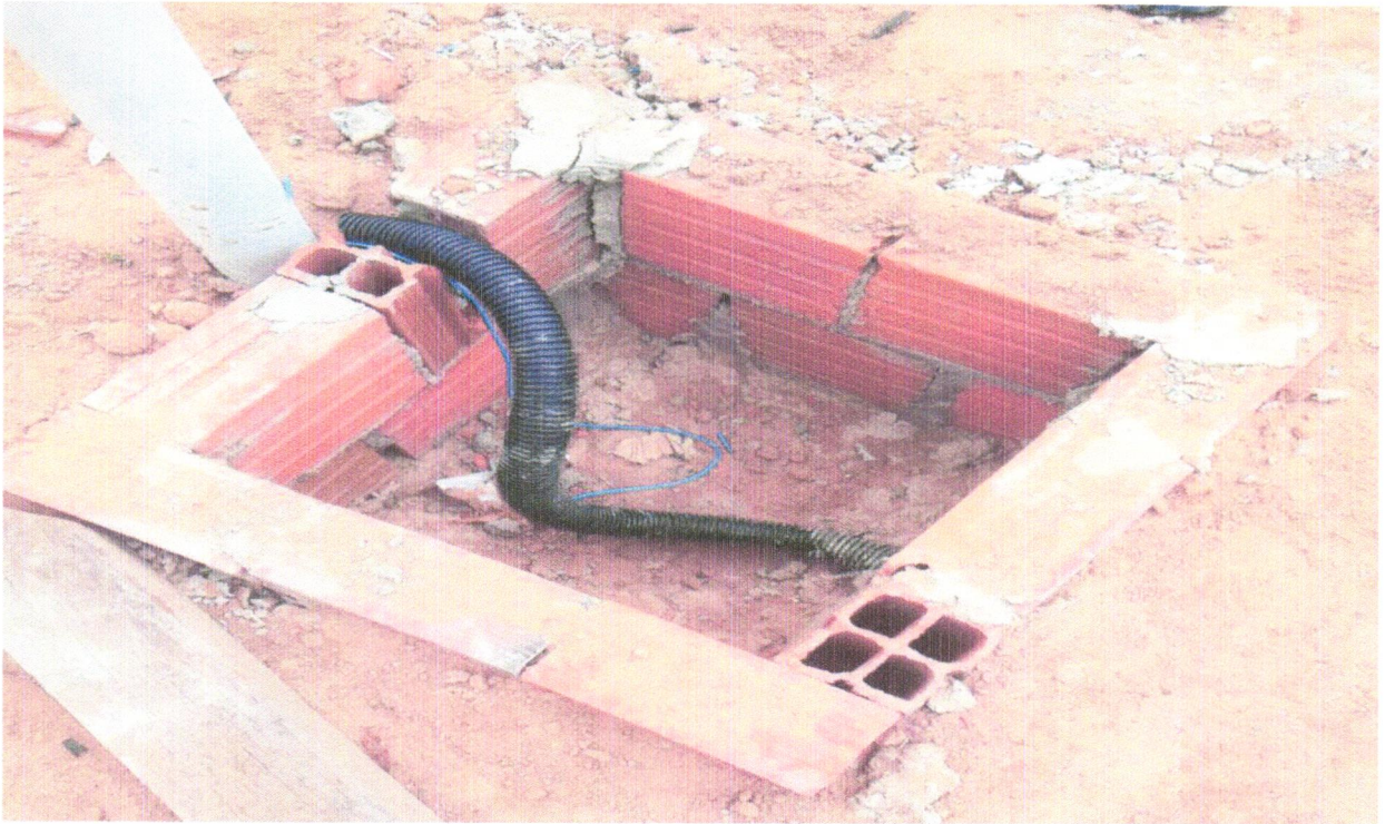
FOTO 32 - ELETRODUTO FLEXÍVEL CORRUGADO, PVC, DN 32 MM (1"), PARA CIRCUITOS TERMINAIS, INSTALADO EM FORRO - FORNECIMENTO E INSTALAÇÃO. AF_12/2015
