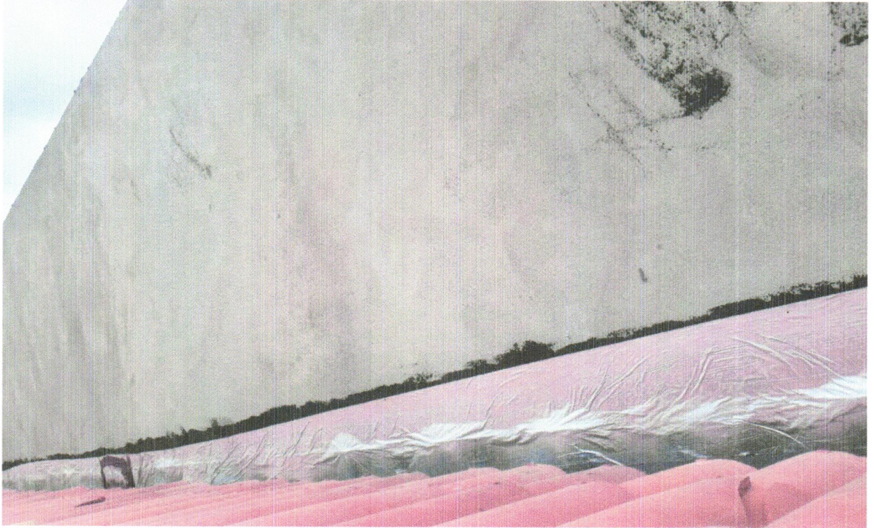
FOTO 30 - RUFO EM CHAPA DE AÇO GALVANIZADO NÚMERO 24, CORTE DE 25 CM, INCLUSO TRANSPORTE VERTICAL. AF_07/2019.
