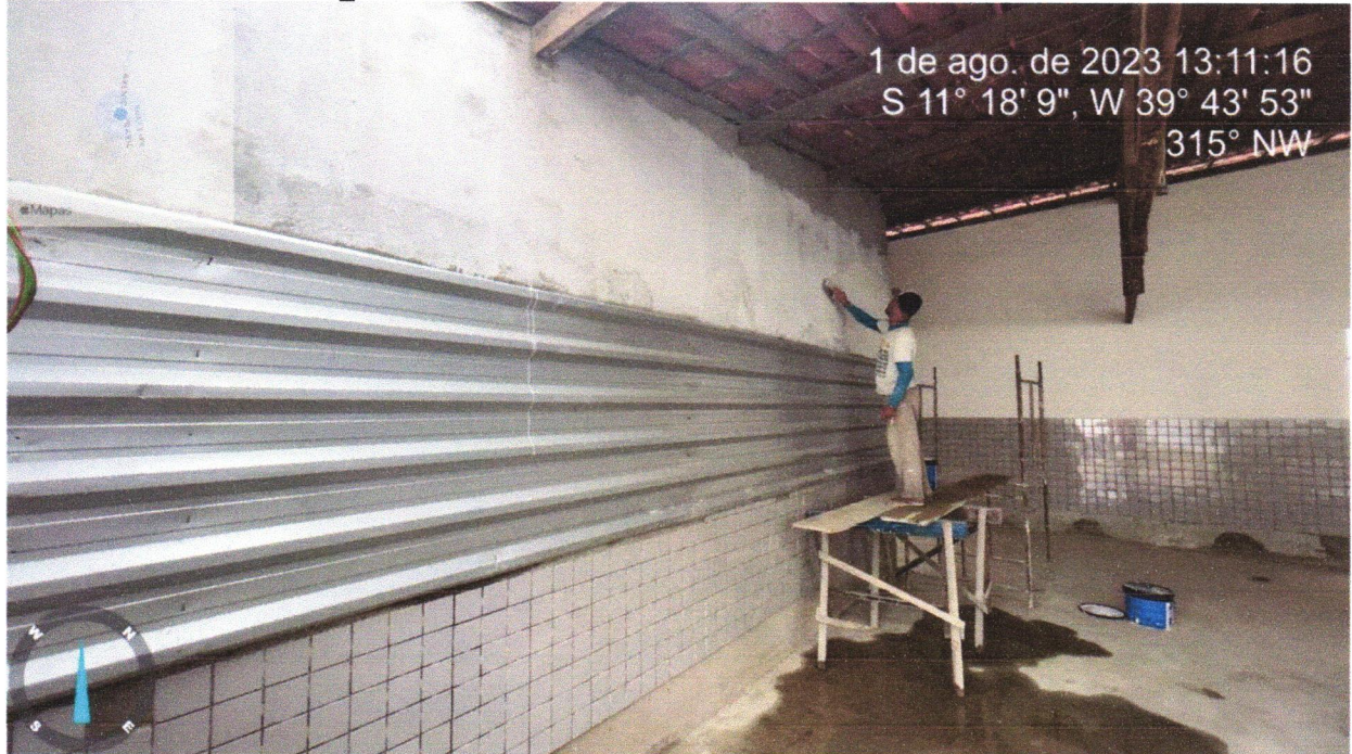
FOTO 16 - APLICAÇÃO MANUAL DE FUNDO SELADOR ACRÍLICO EM PAREDES EXTERNAS DE CASAS. AF_06/2014" "APLICAÇÃO MANUAL DE FUNDO SELADOR ACRÍLICO EM PAREDES EXTERNAS DE CASAS. AF_06/2014
